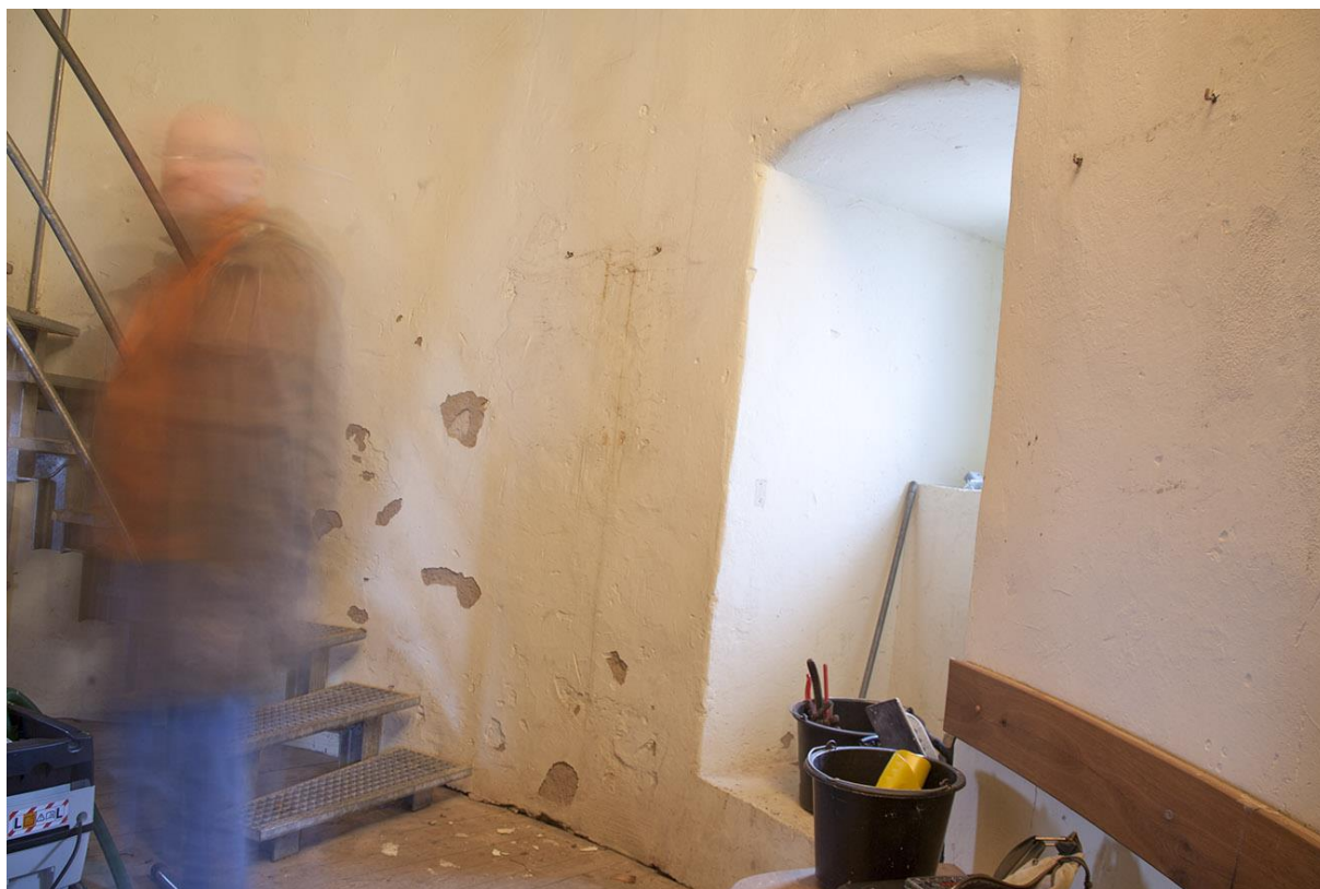
Während der Arbeiten
